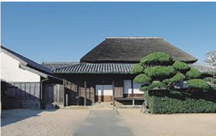
主屋の大きな茅葺き屋根は吉野川が氾濫して万が一の際には船代わりに水に浮くよう設計されている。
